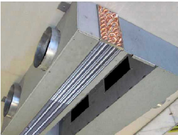
3. Demontage Bodenplatte/Absaugen Wärmetauscher auf Druckseite
