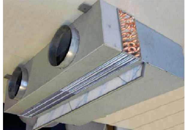
2. Austausch Steckfilter
